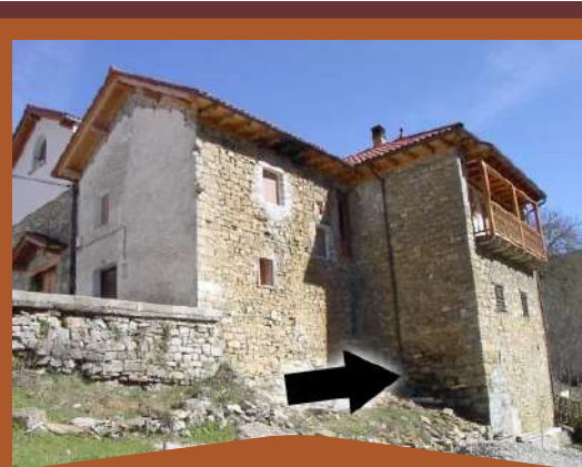
Casa Xoko antes de quemarse, y la flecha señalando la altura a la que quedaría la trampa
